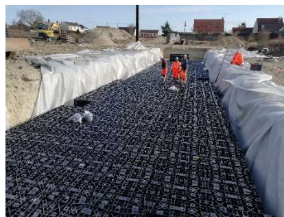
Visite de chantier lotissement à CHAINGY : installation d'un bassin de rétention enterré pour récupérer les eaux pluviales
