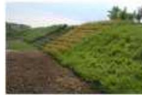
Au sud, en façade de la RD 13, des talus sont recouverts de couvre-sols adaptés. Les arbres sont plantés sur la totalité du merlon. Pour faciliter les arrosages, une bande de gazon de 1m50 est laissée entre la clôture et le pied du talus.
